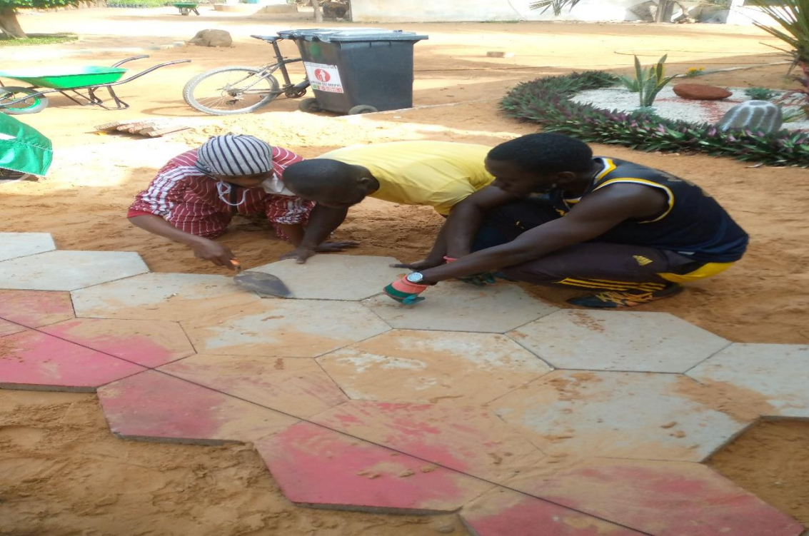
FIGURE 2 MAÇONNERIE PAYSAGÈRE, CONFECTION DE PAVÉS
